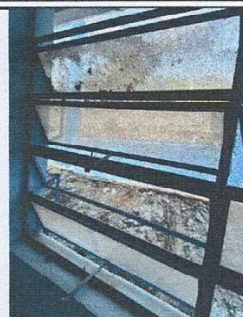
Foto 2: Sustitución de ventanas en mal estado, por ventanas tipo pvc.
