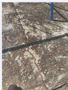
Foto 3: Reparación de losa de patio en mal estado, con un espesor de 8 centímetros.
